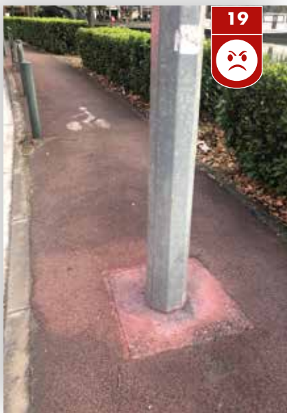
Un trottoir transformé bloquant le passage des cyclistes.
