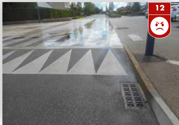
Lors de dépassement de cycliste, l'eau stagnante peut provoquer un éclaboussement susceptible d'engendrer un déséquilibre.
